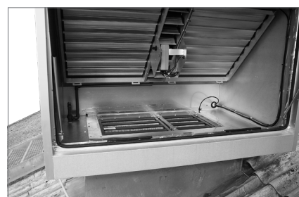
Фиг. 65: Филтър за засмуквания въздух
