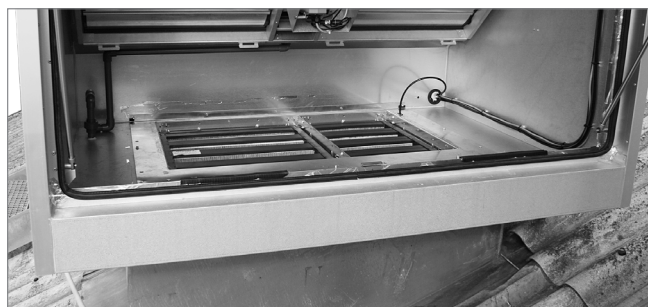
Фиг. 34: Филтър за засмуквания въздух, монтиран в апарата
